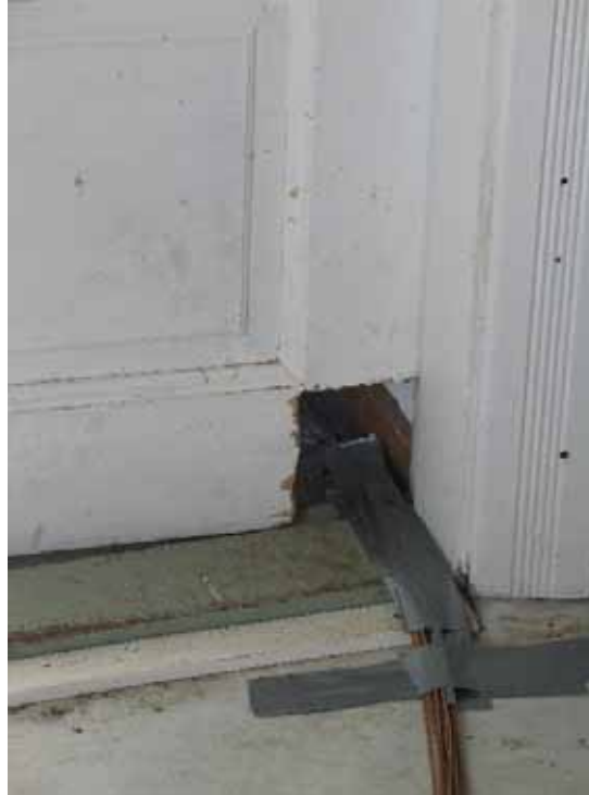
Kuva 65. Termoelementtien johtoja varten oveen 1 porattu aukko.
