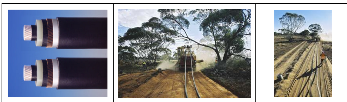
Kuva 4-5. HVDC Light®-konseptin maakaapeli ja sen asennusta [36].
