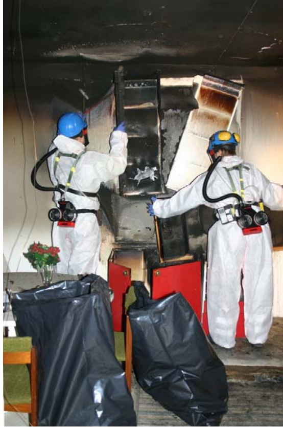
Kuva 46. Koehenkilöiden suojautuminen kokeen 2 saneeraustyössä.
