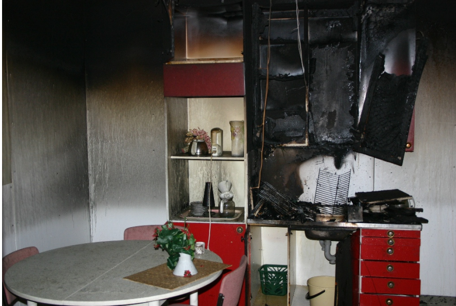
a) Yleisnäkymä keittiöstä polton jälkeen.
